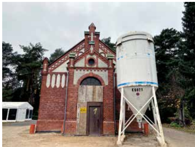
Vorsicht Baustelle: Voraussichtlich im März kann die Friedhofskapelle wieder genutzt werden.
